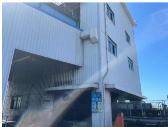
港池东侧码头平台 1#转运站
