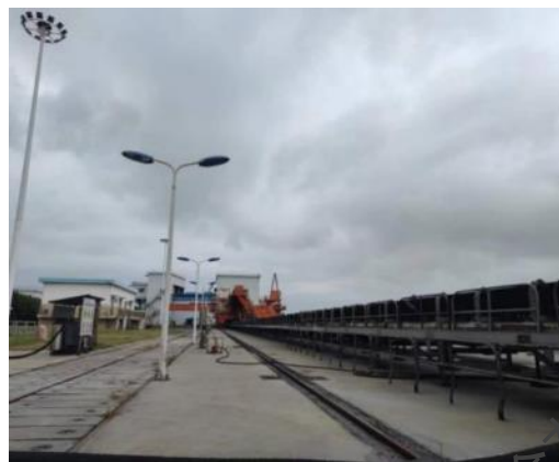
港池东侧码头平台皮带机
