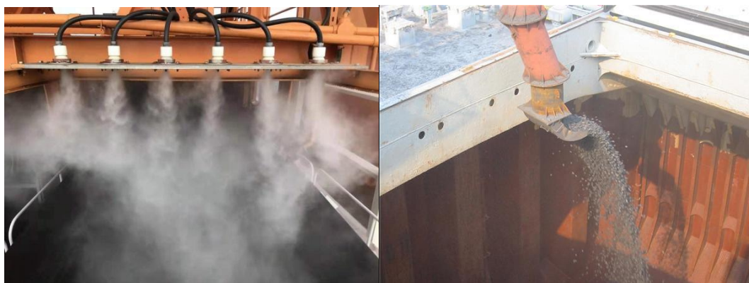
图 7.2-1 前沿喷淋抑尘、装船机溜管封闭及控制作业高度示例图
